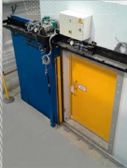
Porte automatique de radioprotection – UK Atomic Energy Agency
