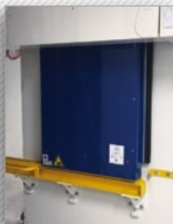
Porte avec trappe motorisée CERN - Genève
