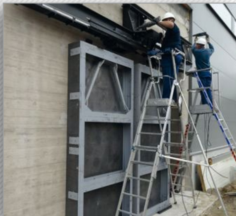
Montage Porte – Centrale Nucléaire Tihange – Belgique
